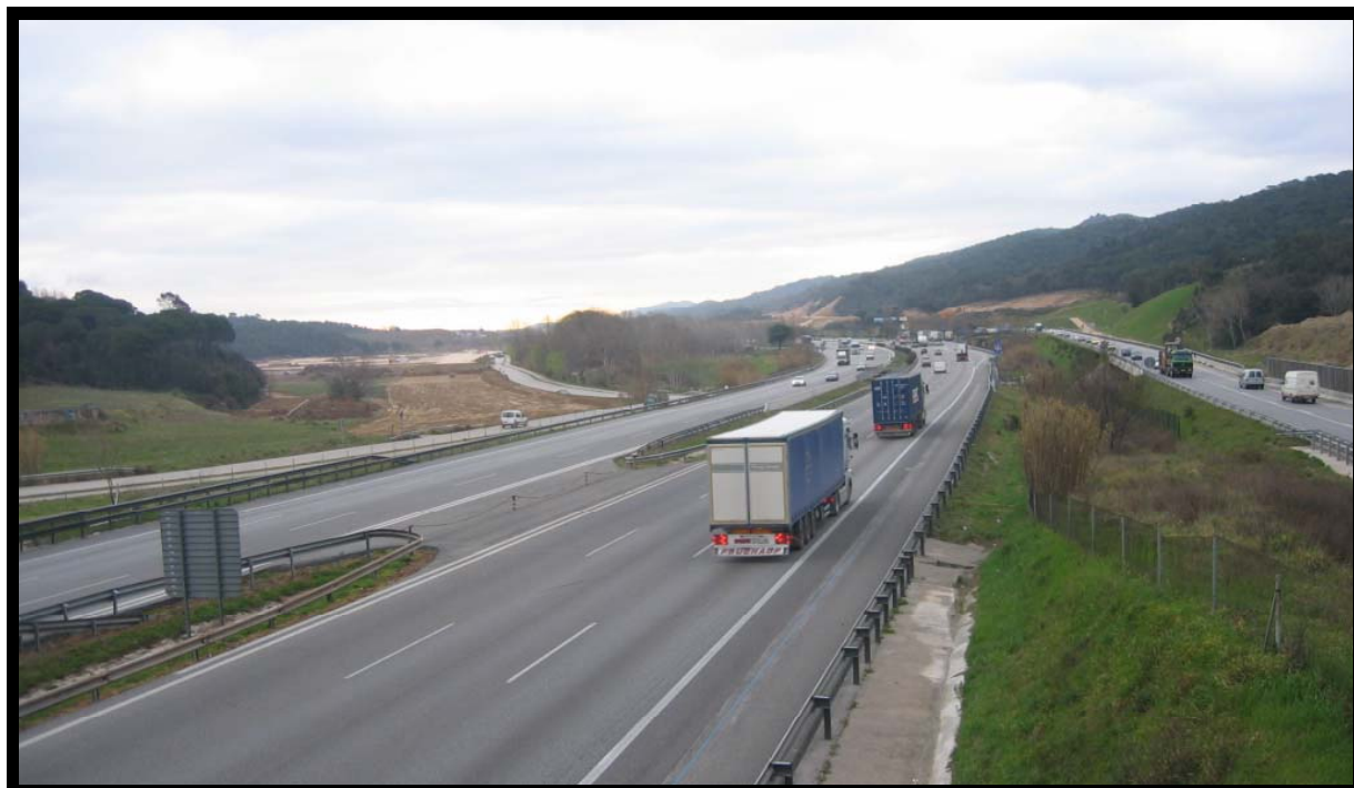
Foto 1. Corredor del Mogent ocupat per diverses grans infraestructures (d'esquerre a dreta): autopista AP-7, variant de la C-35 i nova via ferroviària del TAV en construcció en la vessant de la serralada. Aquest corredor, conjuntament amb les vies locals, suportarà la totalitat de 18 carrils viaris i 6 ferroviaris.
